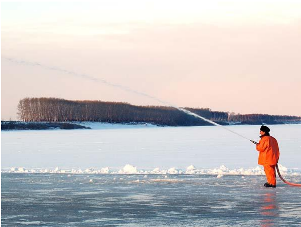
Рисунок 1.9 – Намораживание ледовой переправы при помощи водяной помпы
